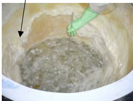
添付資料 11-写真 1（過酸化水素水タンク内部）
