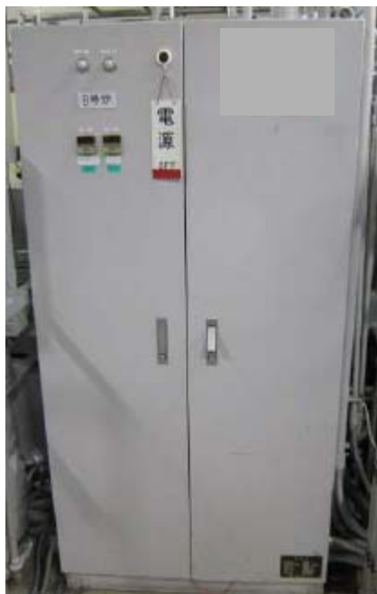
写真2 ガドリニア焼結炉B号機のヒータ電源盤
